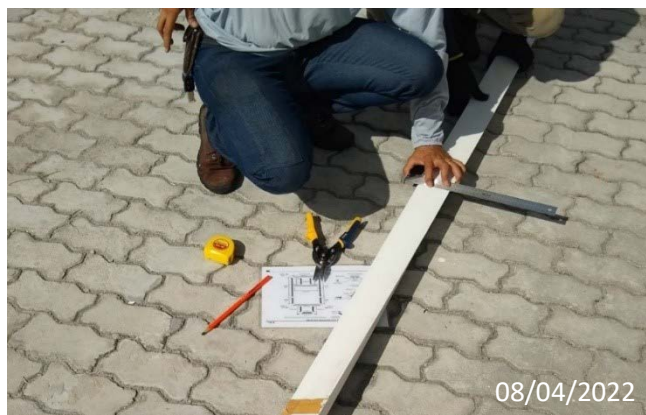
FIGURA 4 — Medição de uma guia de PVC, junto ao ferramental de corte
