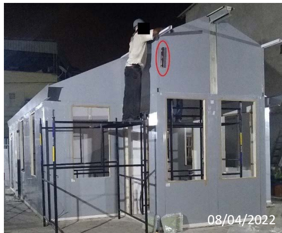
FIGURA 9 — Perfis de aço da estrutura de cobertura e nível de bolha, em destaque
