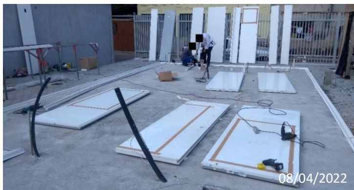
FIGURA 3 — Separação dos painéis
