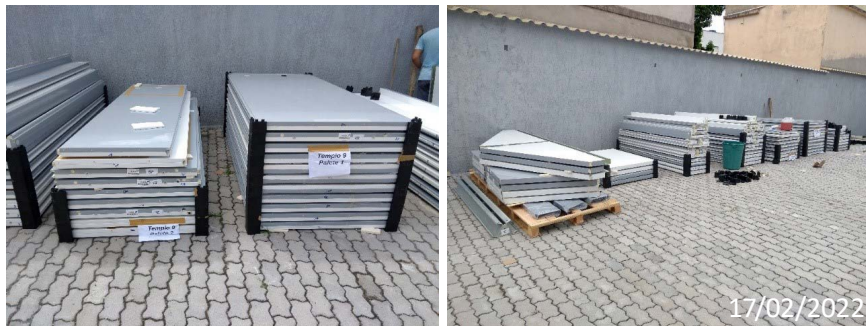
FIGURA 16 — Materiais armazenados de forma adequada no canteiro
