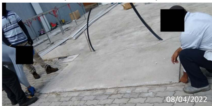
FIGURA 6 — Medição e corte dos cabos de aço
