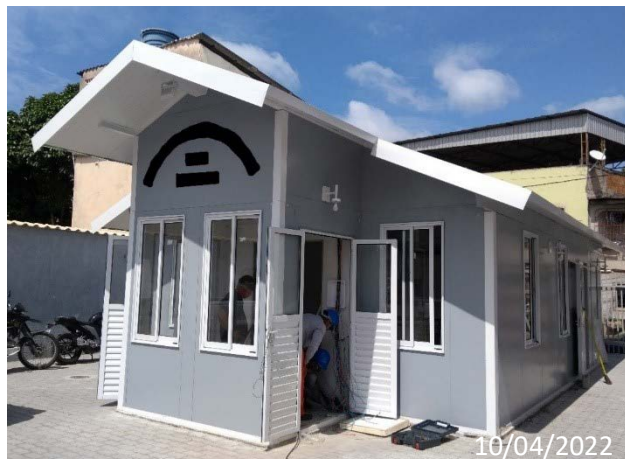
FIGURA 14 — Resultado ao final da obra
