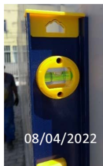
FIGURA 17 — Conferência do prumo dos painéis
