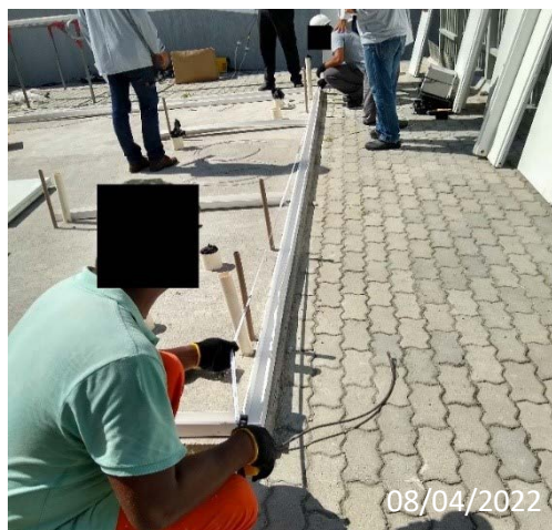
FIGURA 5 — Guia de PVC fixada, tendo seu comprimento verificado
