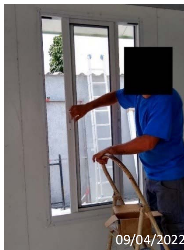
FIGURA 13 — Montador realizando a inspeção de uma esquadria
